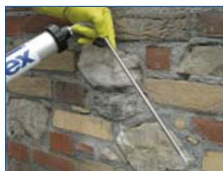
**3.** Scegliere l'ugello della misura adeguata e avvitarlo sulla pistola d'iniezione.
