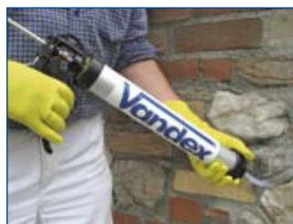
**4.** Riempire completamente i fori con VANDEX IC arretrando fino a 10 mm dalla superficie. Tappare i fori con VANDEX UNI MORTAR 1.
